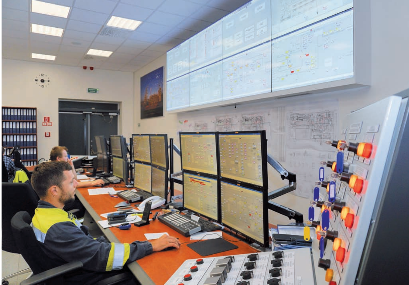
V miestnosti riadenia sa nachádzajú dva blokačné panely, z ktorých jeden je určený na manuálne vyvolanie blokad v rámci systému ESD (na obr. vpredu) a druhý pre systém DCS.
