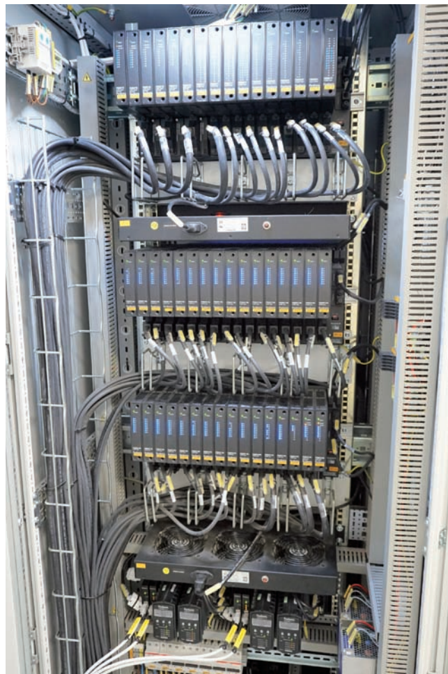
Distribučný riadiaci systém Foxboro Evo od spoločnosti Schneider Electric je základom riadenia prevádzky Čpavok 4.
